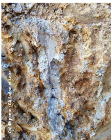
Photo 1 : Sol marqué par la présence prolongée d'eau
